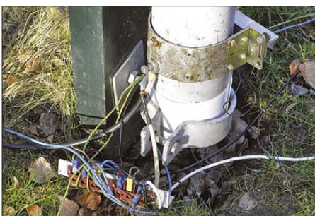
Bild 6: Isolation des Kurbelmastes gegen Masse
